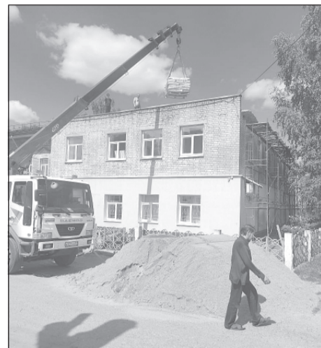
Ремонт школы завершится к началу учебного года
